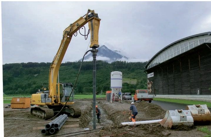
Der Unternehmer Bürgi AG führte die Pfahlgründung für das neue Gebäude Migros Outlet in Alpnach mit verpressten Duktus Gussrammpfählen Ø 250 mm aus.
